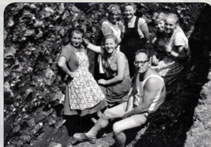
Stanko Pahič z delovno ekipo v izkopu leta 1963
