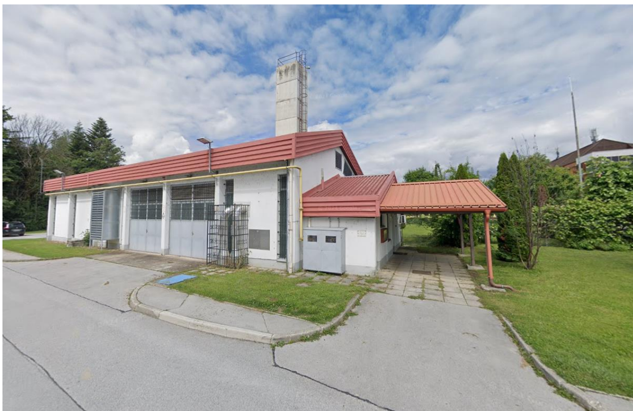
Slika 3: Fotografija območja obstoječe kotlovnice v smeri zahoda (vir: Google maps, nov. 2024)
